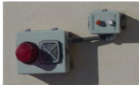
Overfill Alarm
